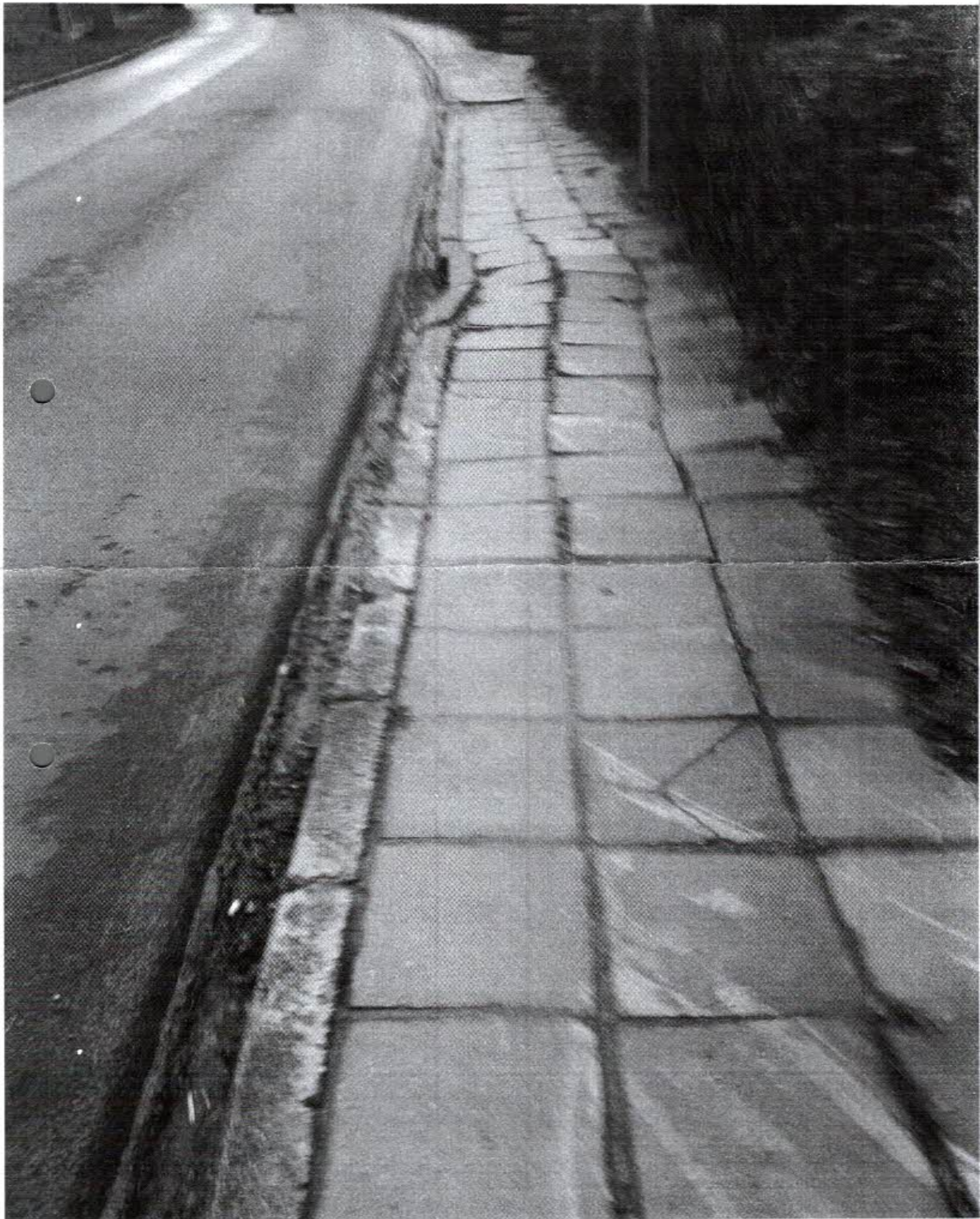
Chodník ul. Niska Brno
